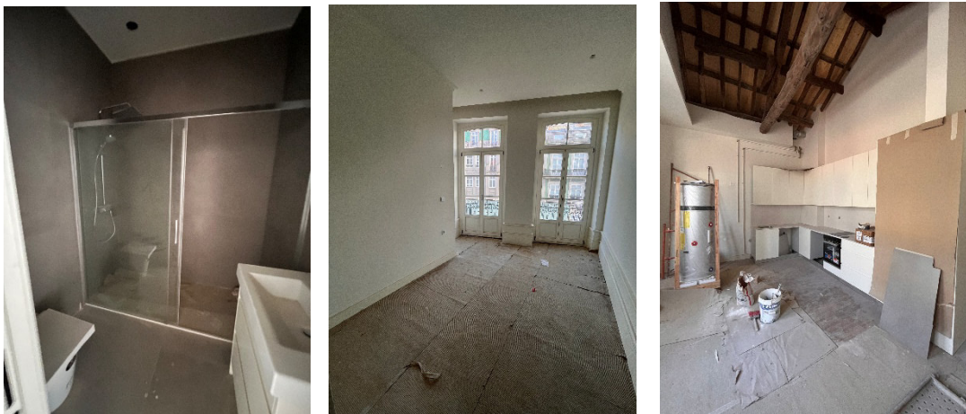
Figura 31 - Fotografias da obra da Rua Mouzinho da Silveira, n.º 133 a 137
