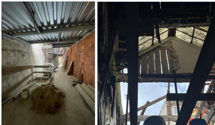
Figura 32 - Fotografias da obra sita na Rua dos Mercadores, nº 168-170
