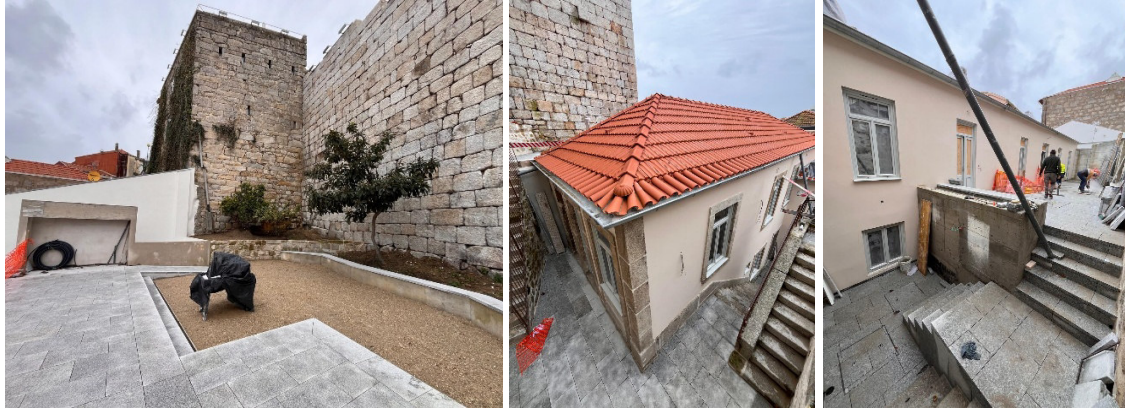
Figura 30 - Fotografias da obra da Rua Francisco da Rocha Soares, n.º 36 a 48
